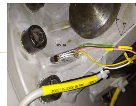
В процессе монтажа
