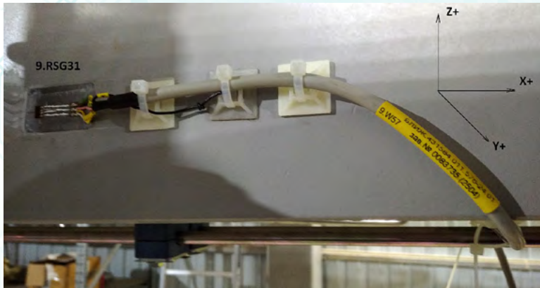
Тензопказатели элементов конструкции (фото в процессе монтажа)
