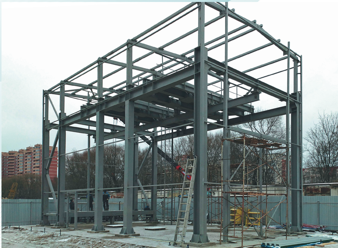
Строительная площадка Цеха испытаний мехатроники (г. Ивантеевка, МО)
